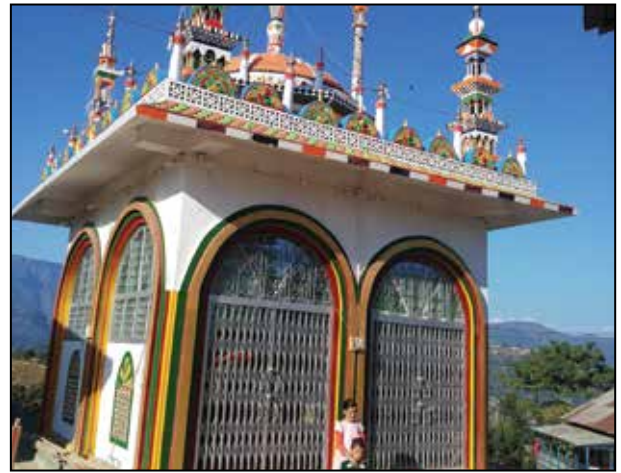
मुस्लिम धर्मालम्बिहरूको लागि इमाम्बडा निर्माण २०७५
