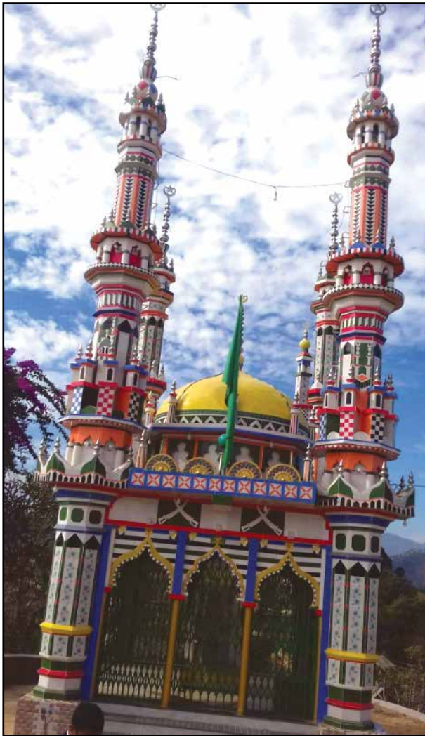
मुस्लिम धर्मालम्बिहरूको लागि इमाम्बडा निर्माण २०७५
